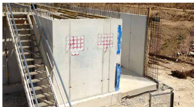
HSI90 après le bétonnage: suit ensuite le raccordement des gaines
