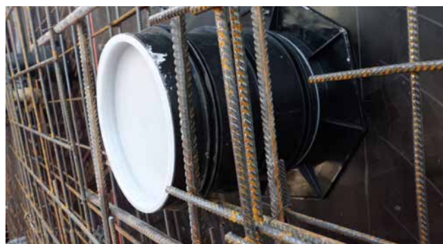
UFR dans le coffrage
