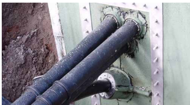
bride fixe/amovible divisée conforme à DIN 18533
