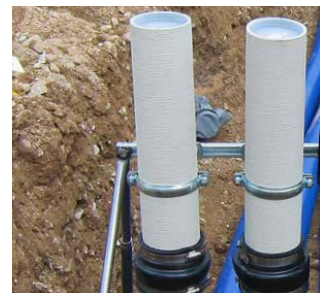
disposition en rangées de 2x KES90 MA ZVR100/500 sur le dispositif d'installation KES FUBO-FIX AV
