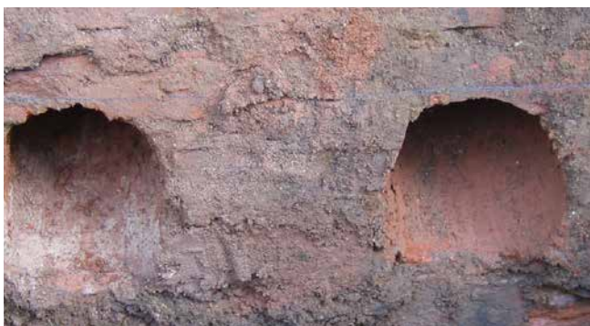
carottage incliné dans un mur poreux
