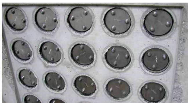
FZR100/240 – étanchement, tracé des tuyaux
