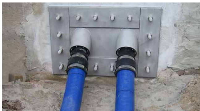
bride fixe/amovible avec raccordement de gaine inclinée avant l'étanchéification superficielle
